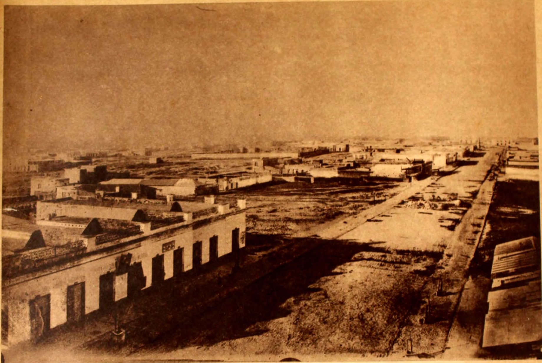
Perspectiva de la calle 18 de Julio en 1866, permitiendo ver las primeras obras de cimentación de la columna.
