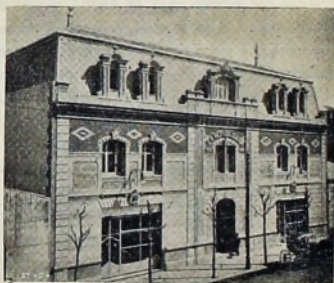
Frente del edificio de «La Republicana»
