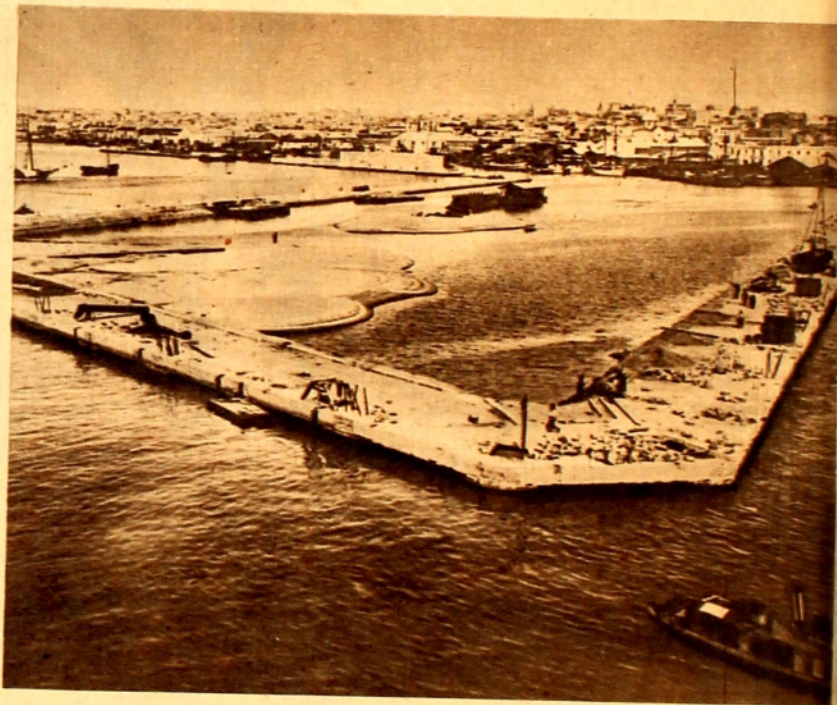
Ejecución del sellamiento en el muelle B.
