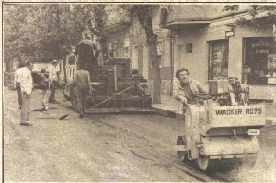
Terminación de capa asfáltica en la calle Jackson.
