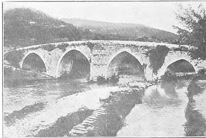
PONTEVEDRA.—Puente de Cernadela
