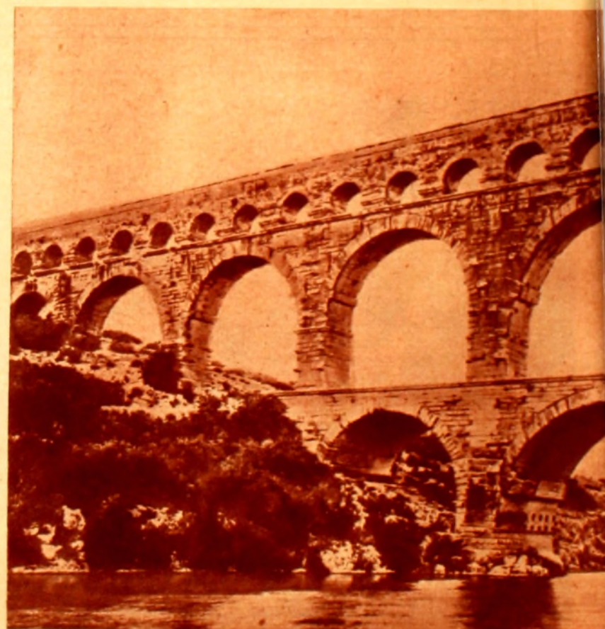
Puente acueducto del Gard (Francia) construido por Agripa (63-12 a. C.). Altura total: m 50. Longitud: m 2
