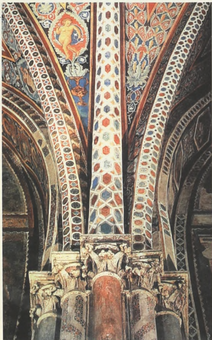
Una de las pilastras sobre la cual se apoyan los nervios de la cúpula de crucería afectada.
