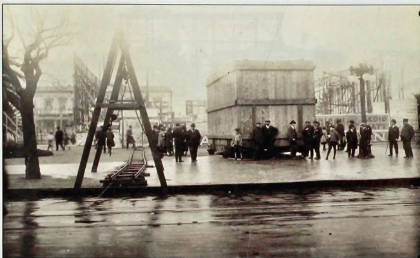
Repechando por Florida, el gigantesco cajón ya ascendió sobre el pavimento de la plaza. A la izquierda se observan unas vías decauville bajo un andamio de fuertes tirantes y llamativas roldanas. Todo había que improvisarlo.
