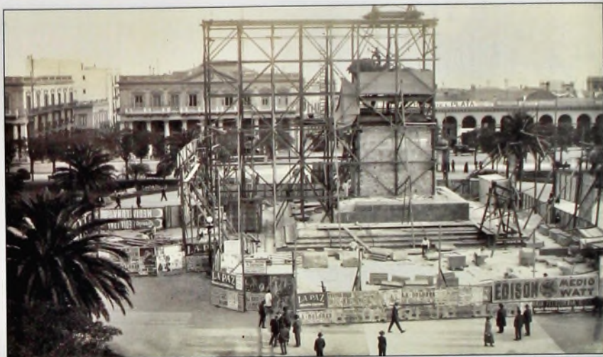
Al fondo, la Casa de Gobierno. En primer plano, cimientos, sólidos andamiajes, poleas, guinches. En lo alto, una vagoneta invertida, sistema ingenioso que se tuvo que improvisar para hacer correr el bronce hasta que ajustara en su pedestal. En curso, se observan los trabajos de revestimiento de marmolería.
