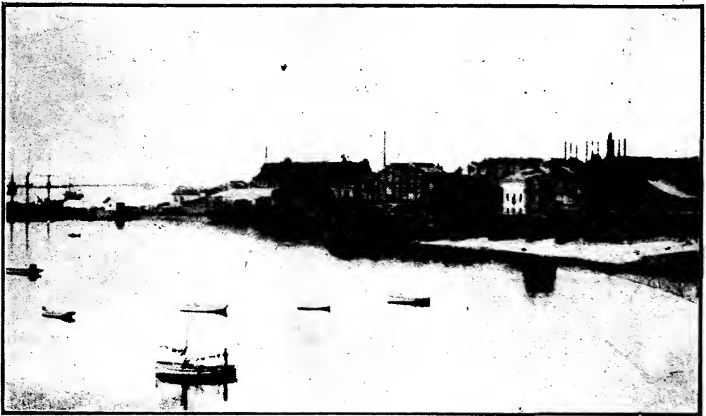
ENTRADA DEL PUERTO DE FRAY BENTOS
