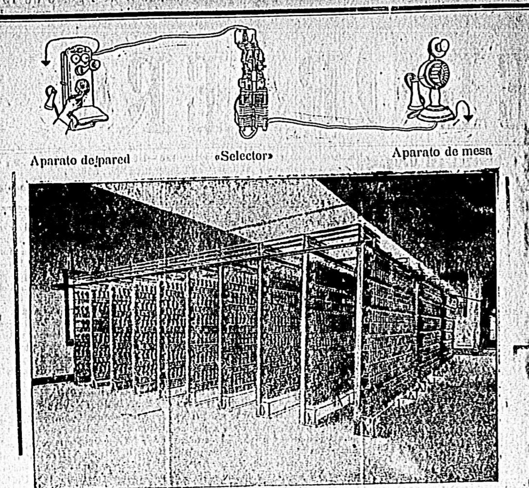
Instalación de una sucursal en California. En cada estantería están colocados los selectores correspondientes a cada aparato telefónico con sus respectivos «conectores» encargados mecánicamente de poner la comunicación con el aparato del abonado con quien uno quiere hablar.
