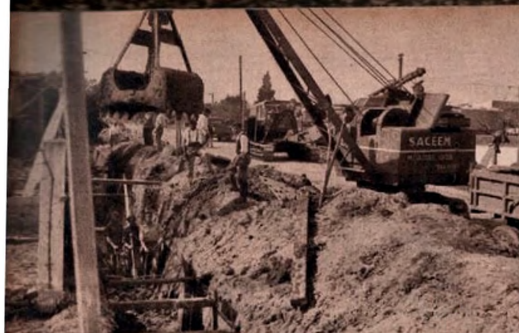
Las obras que se realizan en el Cerrito en la instalación de la 4ª línea de bombeo, que se cumple a 2 y 12 kiló metros por semana, faltando efectuar actualmente 23 kilómetros
