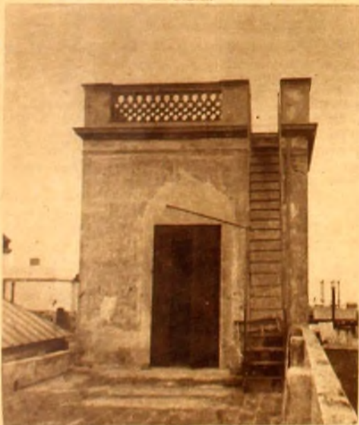
MIRADOR AUN EXISTENTE, DEL CLASICO TIPO ANTIGUO, CON BALAUSTRAS DE TIERRA COCIDA
