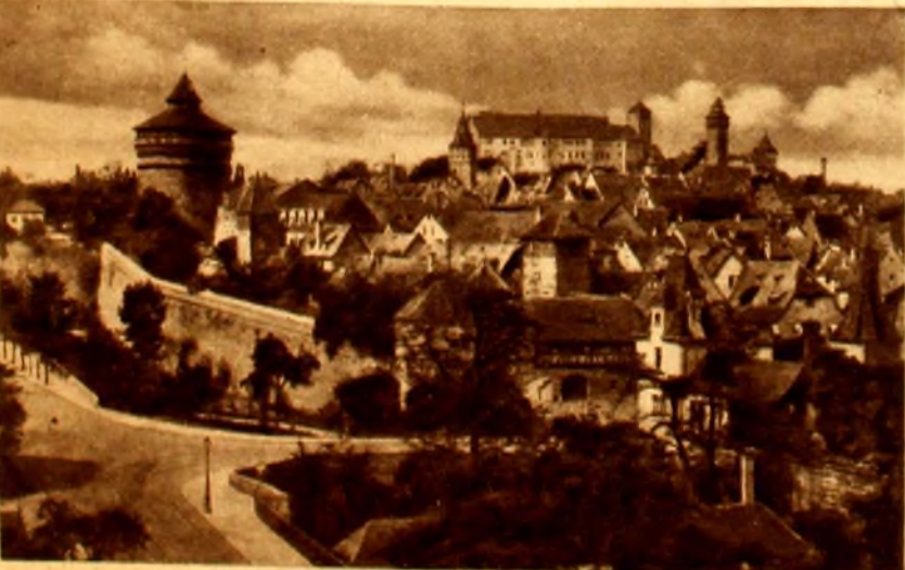
VISTA DE NUREMBERG, CON SUS MURALLAS ANTIGUAS
