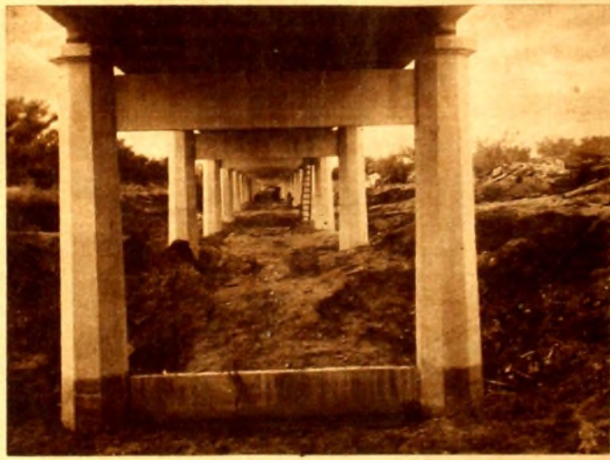
Aspecto del puente, sobre el Cebollati, en la picada de Corbo.
