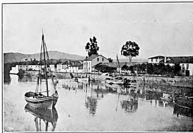
El muelle de Puente Cesures
