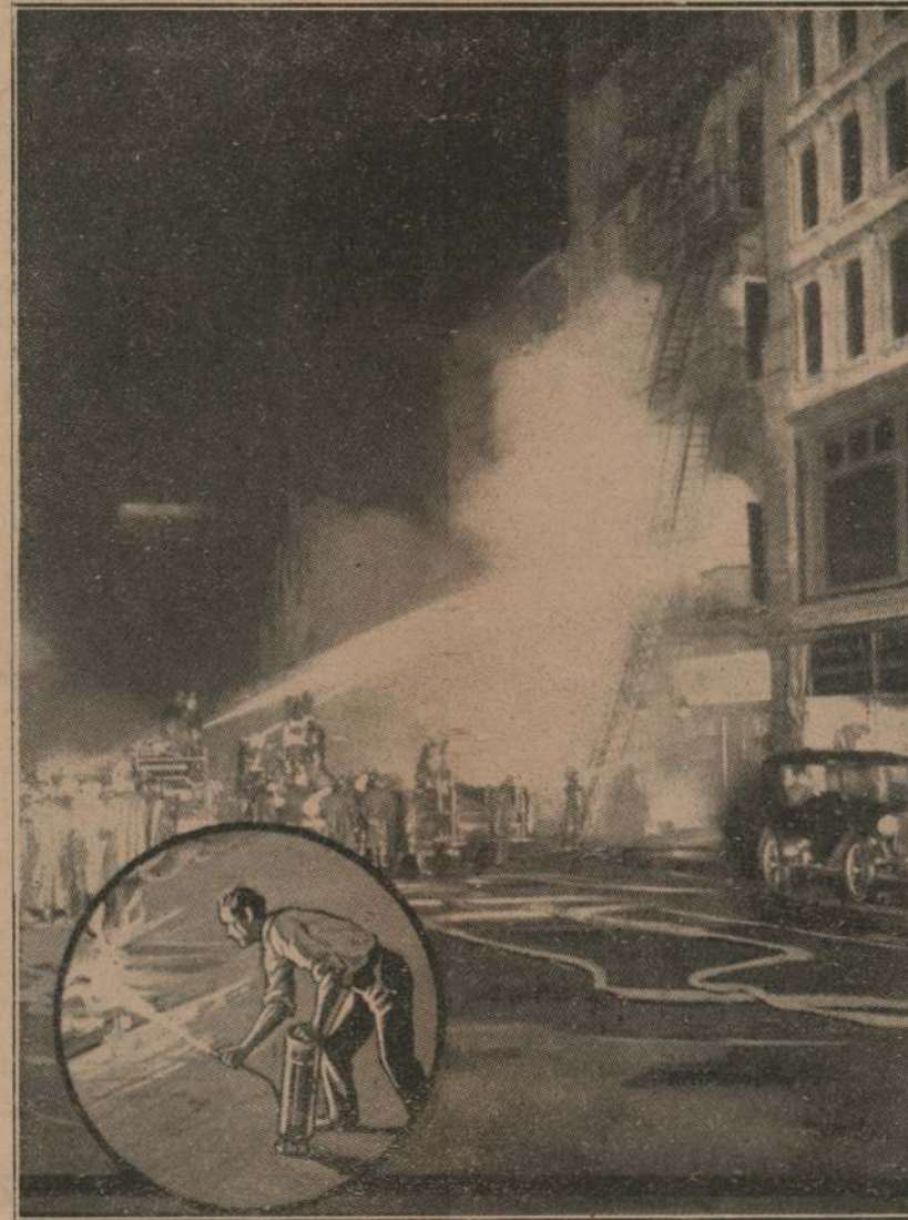
En el primero momento es una chispa, fácilmente dominable con el Extinguidor: más tarde es un enorme incendio que todo lo destruye...
