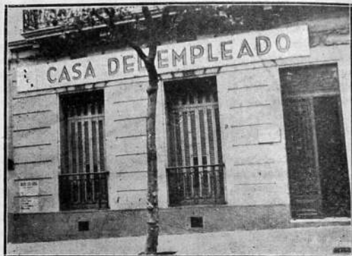
VISTA EXTERIOR DE LA SEDE
