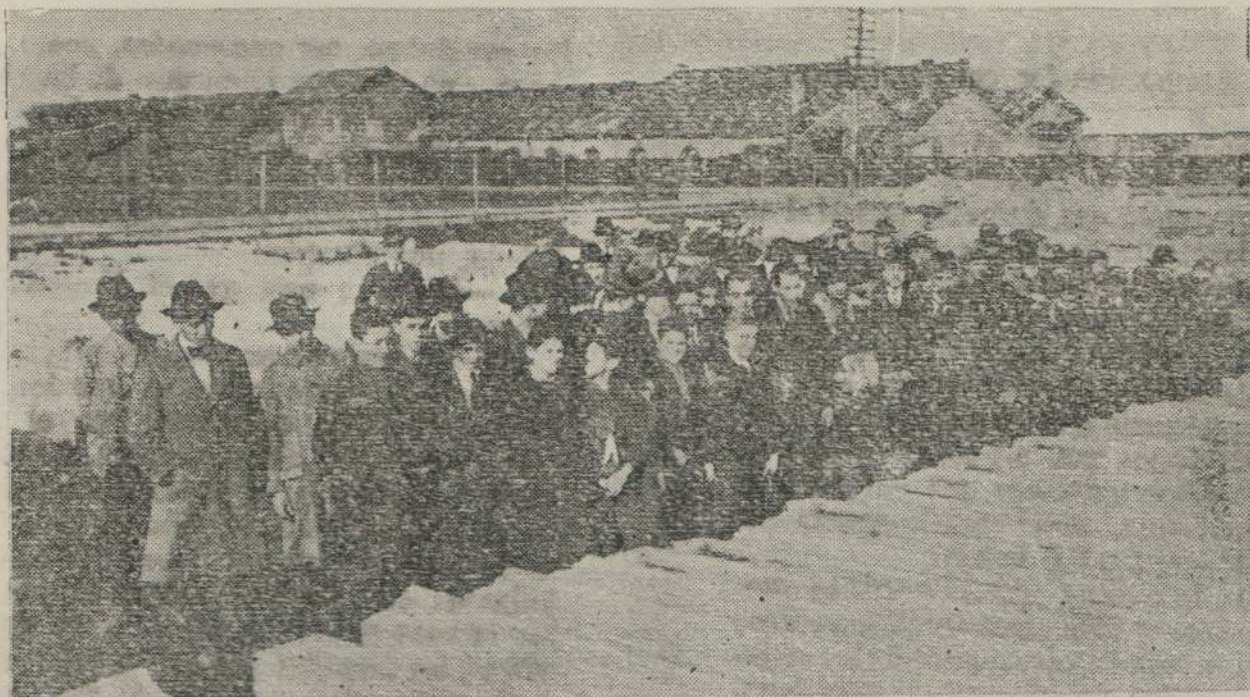
Vista tomada durante la visita de los alumnos y maestros de la Escuela «Artigas» A la Fábrica de materiales de construcción en Bella Vista
