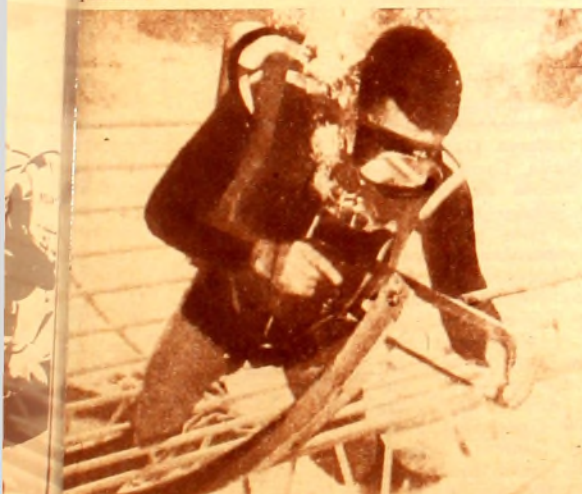
La tarea silenciosa del buzo: uno o varios cables de 15 mm de diámetro trenzados en nylon y polypropileno aseguran la fijez del laboratorio submarino al fondo del mar.
