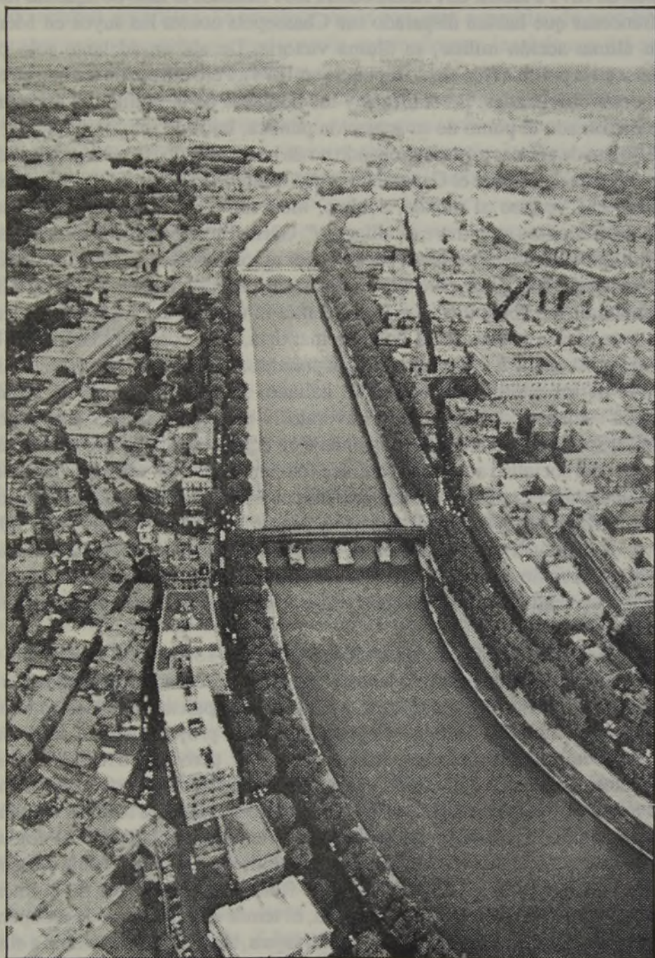
■ Aspecto actual de las obras realizadas por el Ing. Canevari: rectificación del curso urbano del río y construcción de los murallones de contención de las crecidas.
