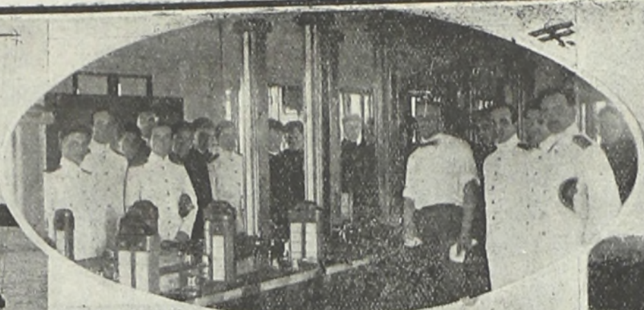
SOBRE LA MESA QUE SE VE EN EL GRABADO Y QUE ES LA DIRECCION DE LA ESCLUSA SE ACCIONAN TODOS LOS MECANISMOS
