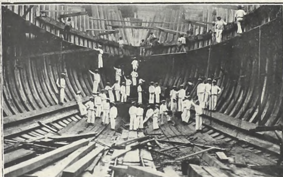
Alumnos de la E. N. asistiendo a una clase práctica de construcción naval en el casco de un barco en construcción
