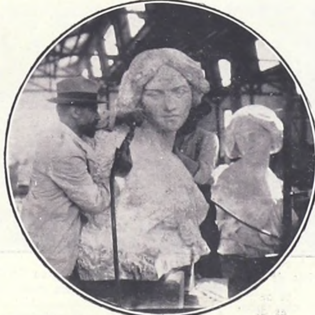
Trabajando sobre uno de los grandes bustos que adornarán la fachada exterior del edificio. Una de las cualidades relevantes de estas efigies monumentales, consiste en que están talladas sobre bloques de una sola pieza.
