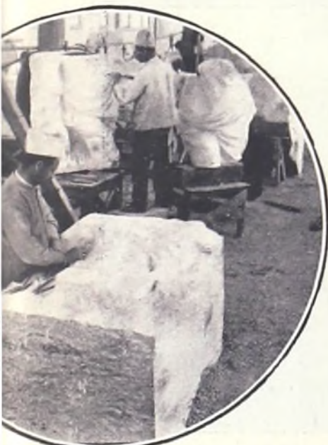
Trabajando un blok, con cincel de mano. El grabado da exacta idea del sólido espesor de los bloques.
