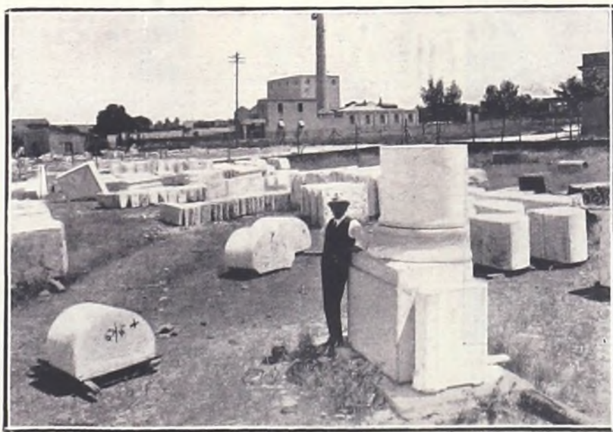
Una serie de piezas ornamentales prontas para ser colocadas. En primer término una columna basamental tallada en una sola pieza de mármol.
