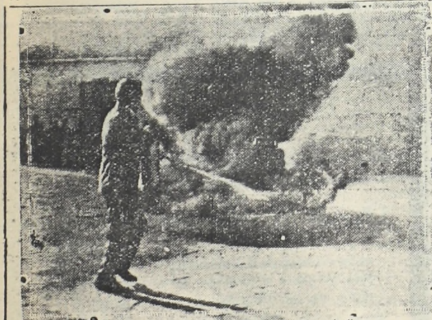
Comprobación de la eficacia del "Foamite" apagando un tanque conteniendo nafta.
