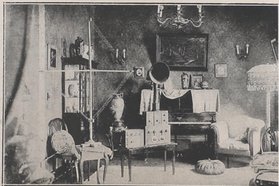
Uno de los receptores Radio Corporation General Electric más completo, instalado en una residencia de Montevideo, haciendo uso de antena interior de cuadro, es decir, sin colocar alambre o poste alguno fuera de la habitación
