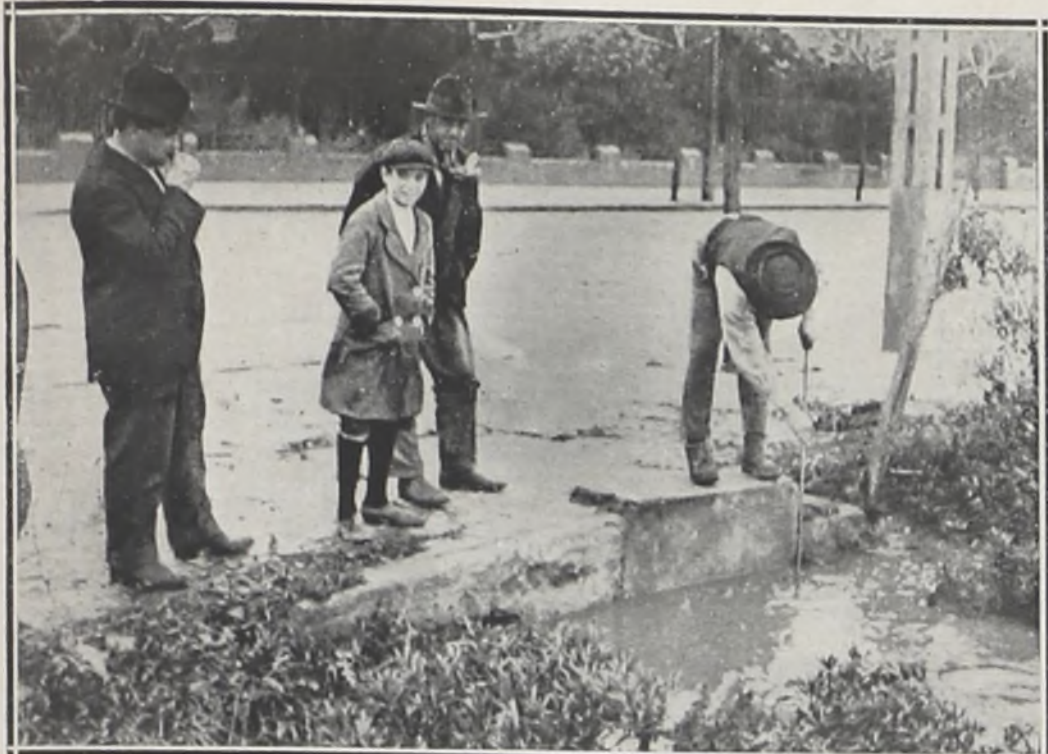
Una de las bocas de agua, en Millán, cuya obstrucción provocó la inundación de aquella zona de la ciudad
