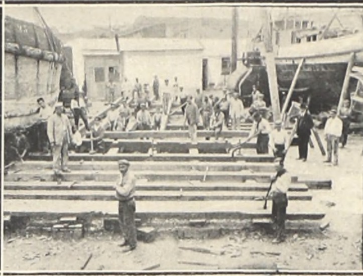
Nueva escala de varar, en el Astillero de la Administración N. del Puerto
