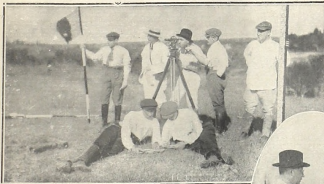
Trazado del eje de operaciones
