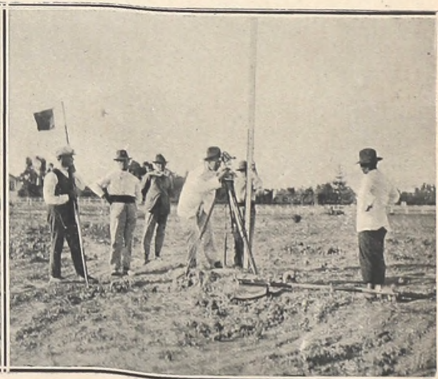
Recificando distancias con el teodolito-taquímetro
