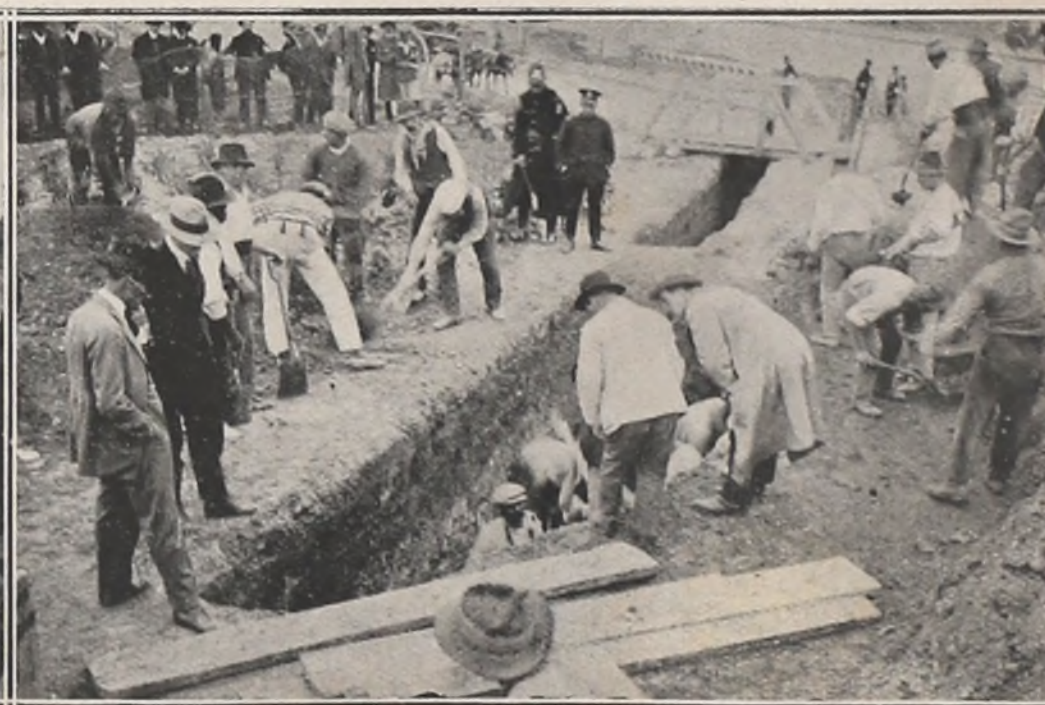
Lugar donde se produjo el derrumbe de las excavaciones para las obras de saneamiento, que costó la vida a uno de los trabajadores
