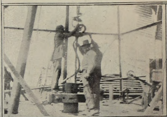
El capataz señor Poggi Damborearena, con dos obreros, en el momento de sacar una mecha perforadora de profundidad de 150 metros
