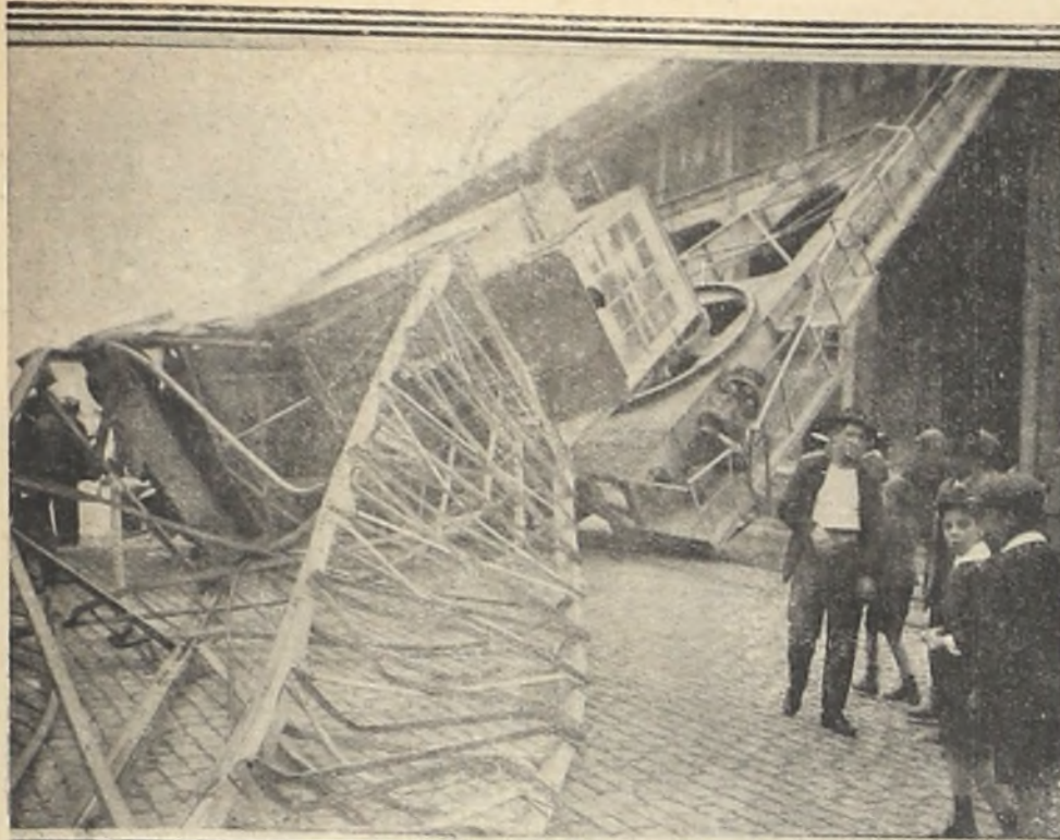
Una de las grúas de pórtico del Puerto derrumbada por la violencia del ciclón, contra uno de los muelles
