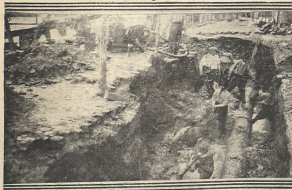
Frente al Palacio Legislativo, arreglando uno de los caños primarios de las aguas corrientes que reventó
