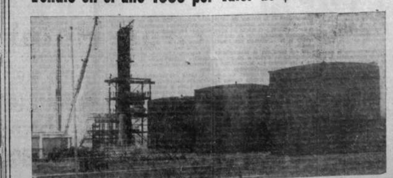
Un aspecto de la Refinería en construcción. Muy pronto esta magna obra será realidad magnífica, sobre la que descansará la gran cúpula de la independencia integral del Uruguay.
