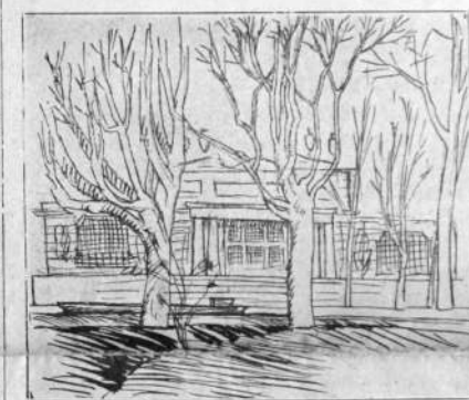
Vista general de la fachada del nuevo Hotel del Prado con la explanada fronteriza en la que se está instalando la fuente Cordier
