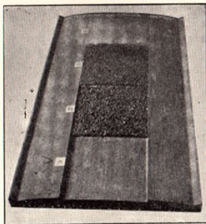
Modelo del procedimiento seguido para la construcción de un camino de macadam
