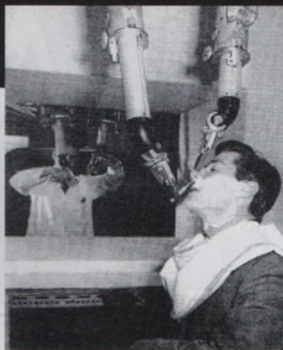
Mayo de 1995. Un hombre afeita a otro para demostrar el funcionamiento de los brazos mecánicos utilizados en investigación nuclear.
