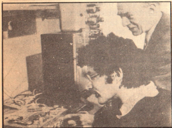
La L.I.F.S. dispone de calificados profesores. Aquí un ex-sonidista de los estudios ingleses de la MGM explica a un alumno, la técnica del repicado de un Nagra IV.
