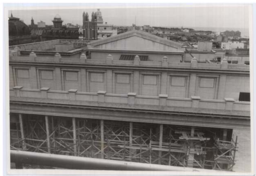
Figura 5. El frente del edificio en obra. BN. Materiales especiales. ABN 7338.
