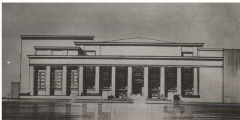
Figura 3. Fachada del edificio. BN. Materiales especiales. ABN 7416.
